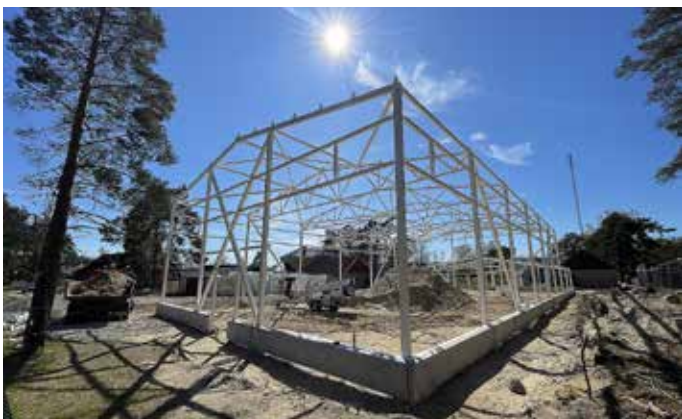
Grundkonstruktionen till nya idrottshallen är redan på plats.
